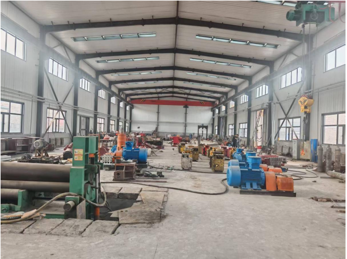
图 1 维修厂房全景图
